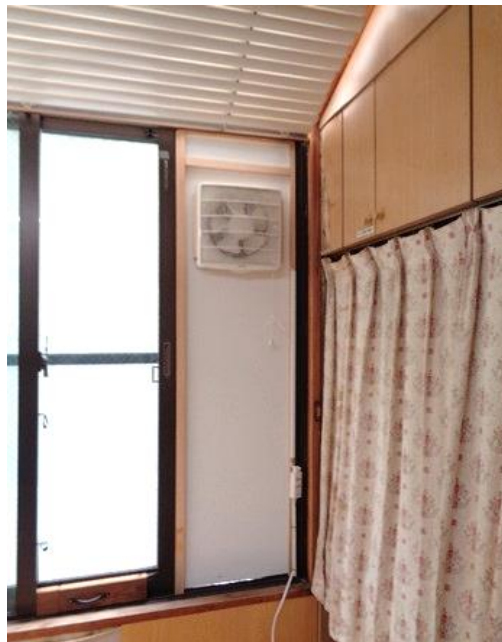
添付・写真17 室内に換気扇の設置
