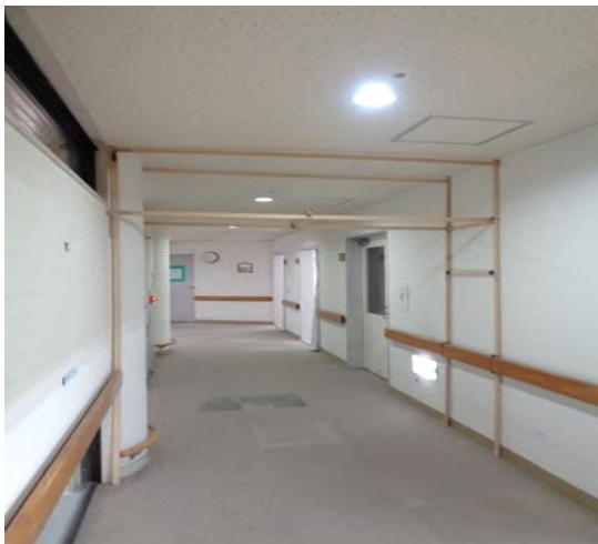
添付・写真16 室外通路にパーテーション用枠を設置。
